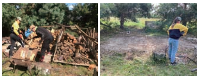
作業③古い薪小屋を片付け、一度更地にする
